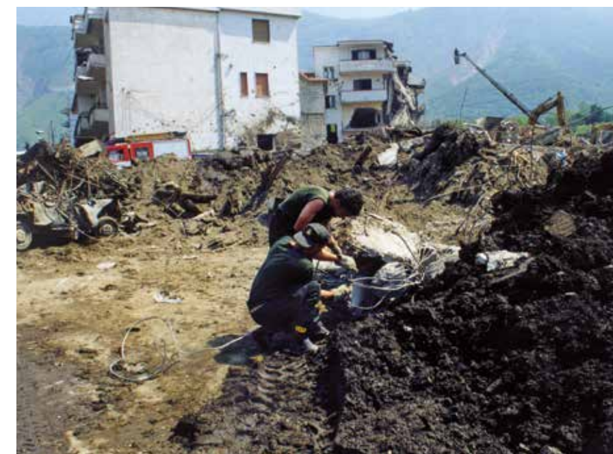
Foto 41. La frana di Sarno del maggio 1998.
