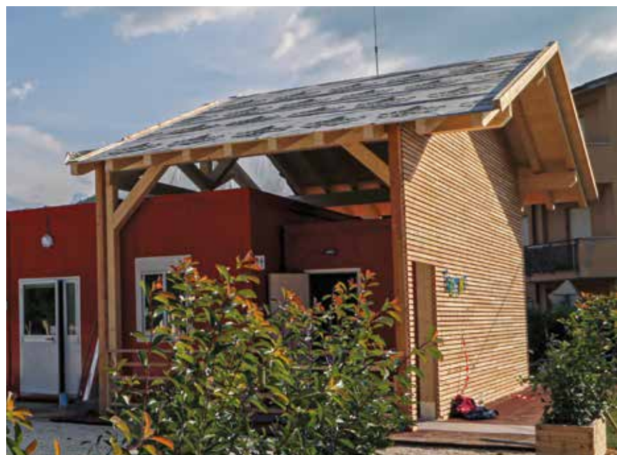
Foto 115. Amatrice, 2016. MUSP-Moduli a Uso Scolastico Provvisori realizzati dopo il terremoto nella frazione di San Cipriano dalla Protezione Civile della Provincia Autonoma di Trento.
