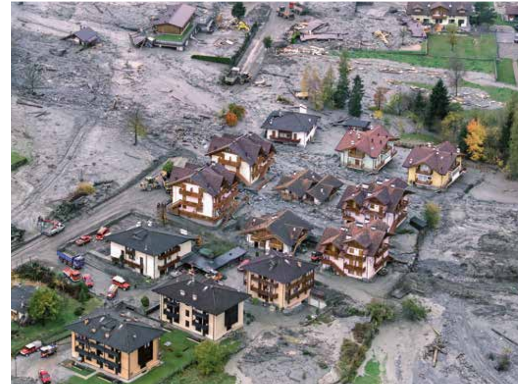
Foto 2. Dimaro, Trento, 2018. Danni alle abitazioni causati da un'eccezionale ondata di maltempo.
