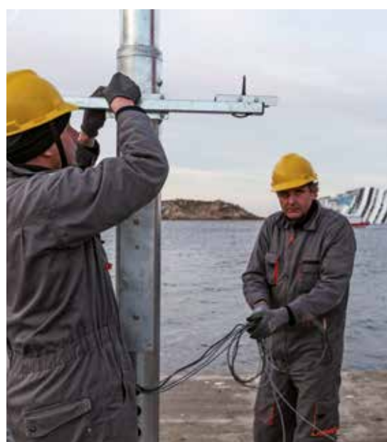
Foto 123. Isola del Giglio, Toscana, 2012. Tecnici al lavoro nell'area del naufragio della nave da crociera Costa Concordia.
