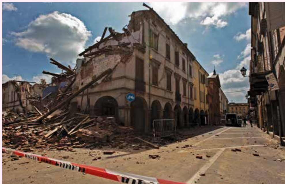
Foto 58. Concordia sulla Secchia, Modena, 2012. Danni provocati dal terremoto del 20 maggio.
