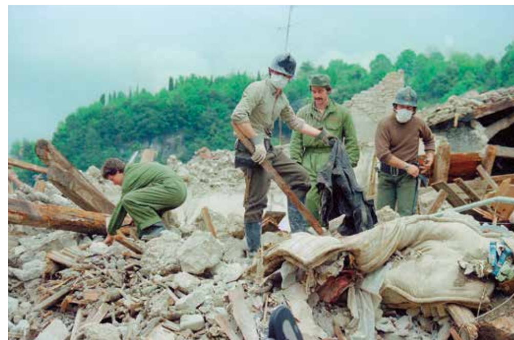
Foto 29. Squadre di soccorritori all'opera in seguito al terremoto in Friuli.
