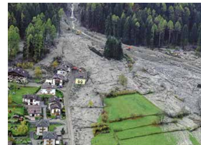
Foto 112. Trento, 2018. Danni alle abitazioni causati da un'eccezionale ondata di maltempo.
